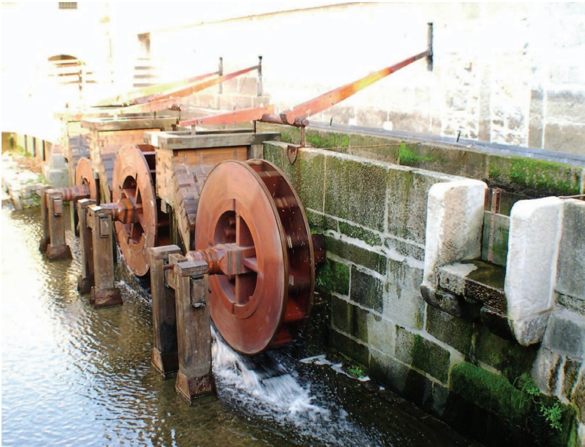
FIG. 13 Las tres ruedas del taller de herrería con sus saetines. El conjunto de palancas articuladas de la parte superior son los dispositivos que permiten subir o bajar desde el interior de la fábrica cada una de las compuertas.
