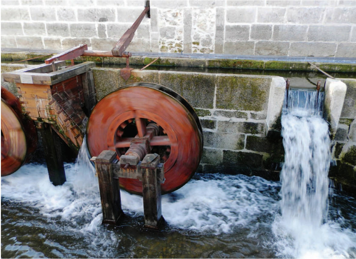
FIG. 15 Funcionamiento de la rueda que mueve el torno. El agua tras impulsar las palas cae al canal inferior por donde retorna al río. El canal elevado, de granito, dispone de un desagüe aliviadero para dar salida al agua excedente.
