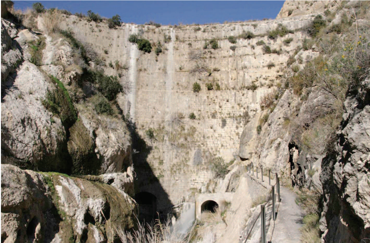
FIG. 14 Presa de Tibi, en el río Monnegre (Alicante).
