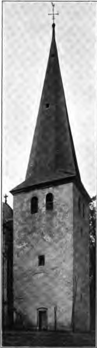
Nordostansicht des Kirchturmes.
