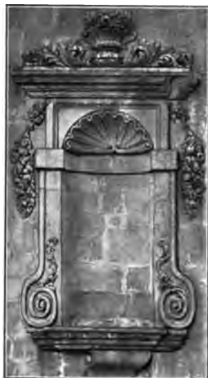
Detail der Westseite.
