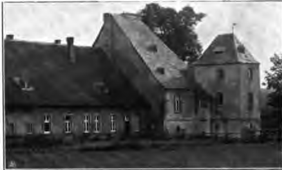
Ansicht von Nordosten.
