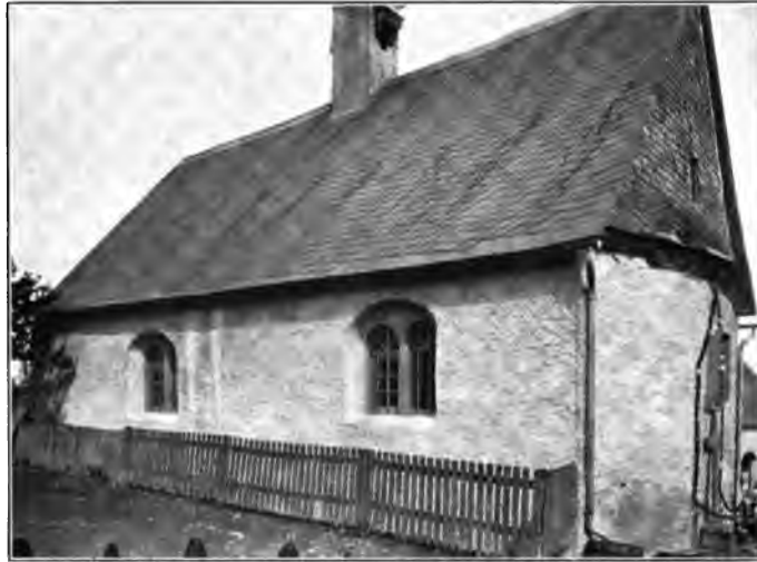
Südostansicht der Kapelle.
