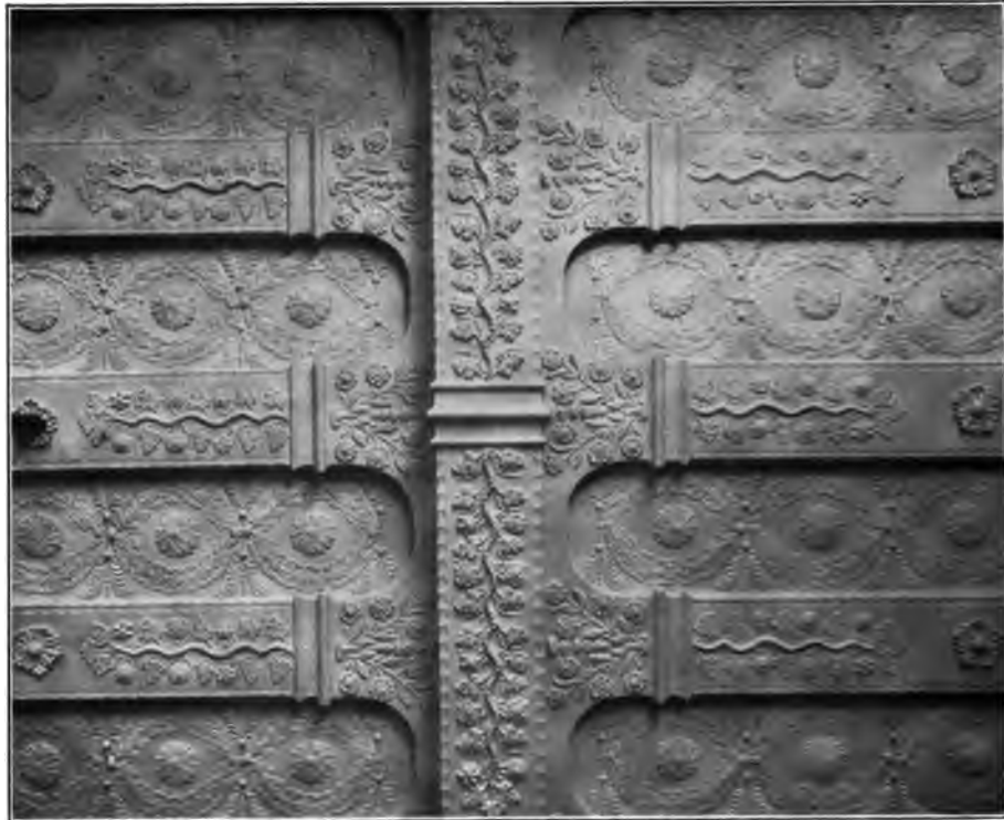
Stuckdecke (Schloß Schnellenberg).
