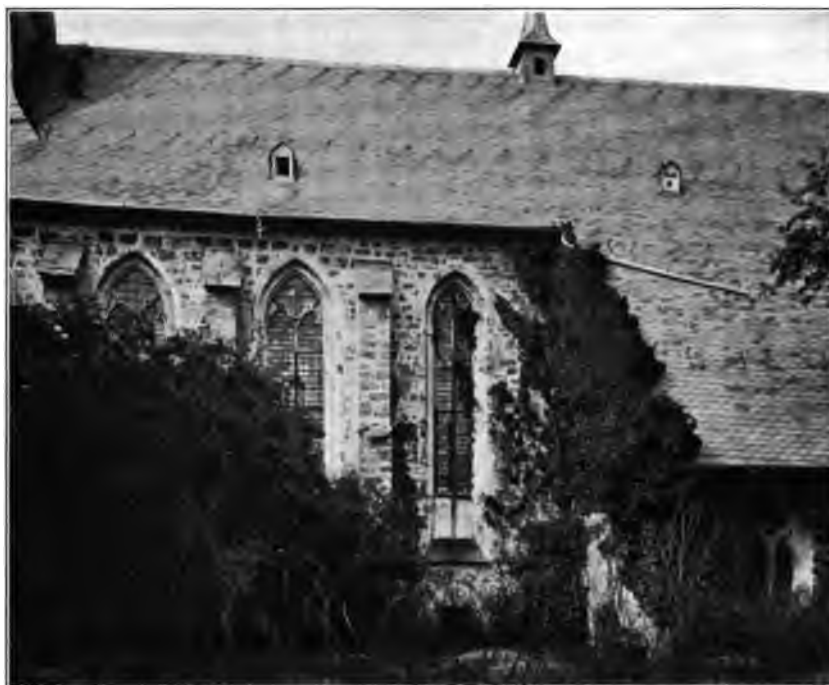
Teil der Südseite.
